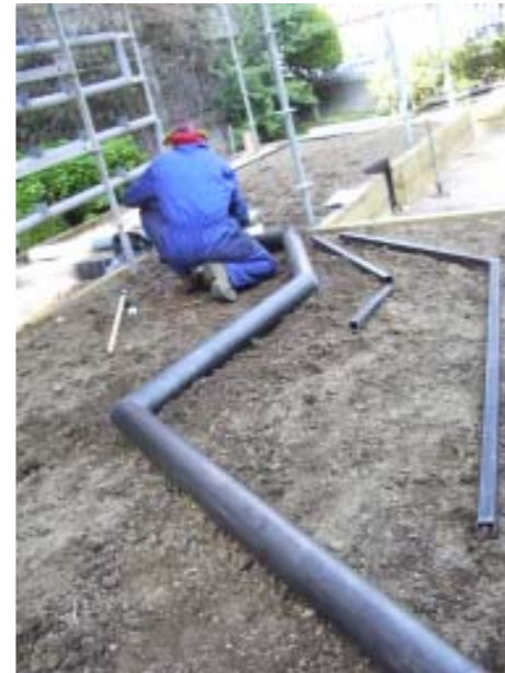
perfiles (40x40 y e=3 mm) y tubos (110mm diam.) de acero oxidado
